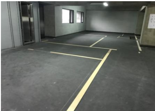
按放樣之記號進行輕隔間骨架施工
