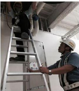
合梯底座(絕緣套)、 穿絕緣鞋及夥同作業
