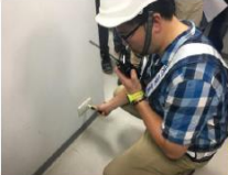
檢測已斷電成功
