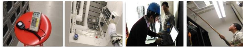
門禁系統測試 機房連動測試 IAQ空氣品質測試 風量平衡測試
